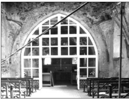
BIRKHOLZ — Stützgerüste im durch ein Glasdach provisorisch geschützten Kirchenschiff Foto: Janowski
