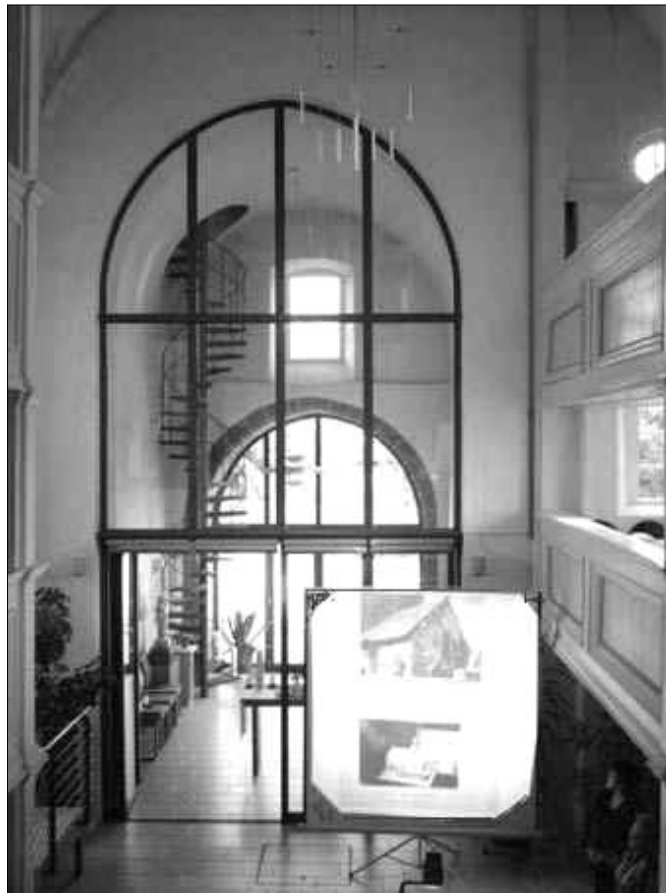
DORFKIRCHE WALTERSLEBEN (Thüringen). Durch eine räumliche Trennung und behutsame Einbauten wurde die gemeinsame Nutzung des Kirchenraumes durch Kirchengemeinde und Kommune ermöglicht.
