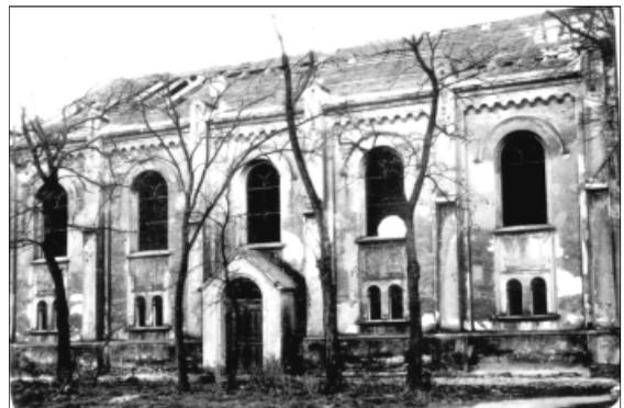
Die Baugeschichte der Kirche von Platkow (Märkisch-Oderland) ist lang. 1836 begann der Neubau auf mittelalterlichen Gebäuderesten, 1856 wurde ein Turm angefügt, aber bereits 1877/1878 erfolgte ein kompletter Umbau im Rundbogenstil der Stülerschule. Bruchstücke einer Kanzel aus dem mittelalterlichen Vorgängerbau kamen ins Schloss Gusow. Die zentrale Lage auf dem Dorfanger machte die
