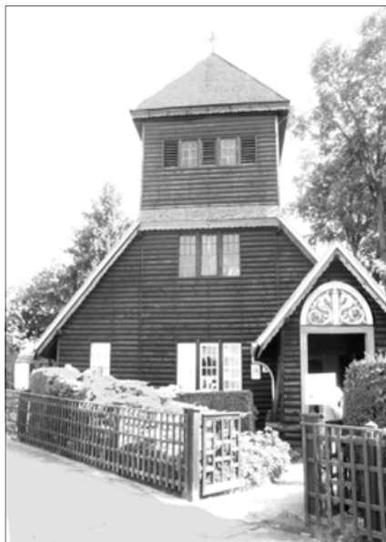
Die HEILANDSKAPELLE wurde 1915 von Russen erbaut. Foto: E. Gonda
