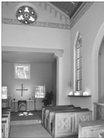
DIE RESTAURIERUNG lässt die ursprüngliche Konstruktion im Raum wieder erfahrbar werden.
