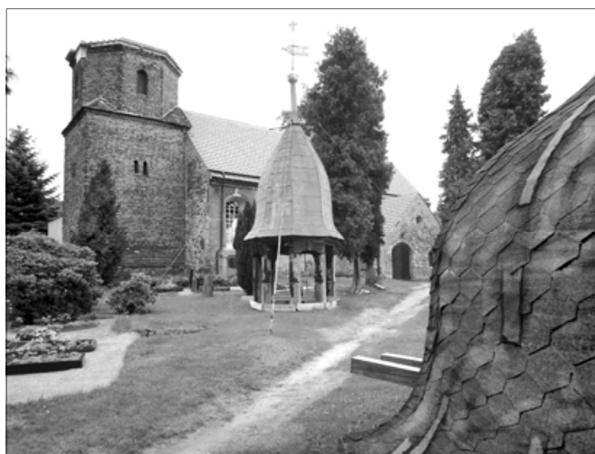
MIT DEM KIRCHTRUM soll auch die gewohnte Silhouette von Laubst wieder hergestellt werden. 2012 wurden zunächst die Laterne mit Wetterfahne und Kreuz und dann die geschweifte Haube abgenommen und auf dem Friedhof abgesetzt.
