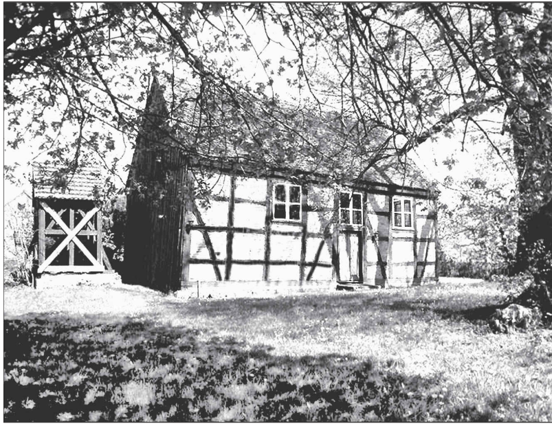
DIE MANSFELDER KIRCHE wurde zuletzt 1931 repariert. Das Fachwerk des Kirchenschiffs und auch der freistehende Glockenstuhl sind heute im Bestand gefährdet. Foto: Meyer-Rath
