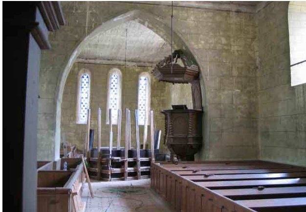
Schalung für die Stampflehmwand im Chorraum der Lindenhagener Kirche
