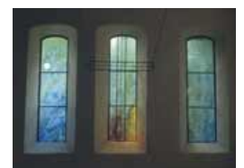
Fenster an der Altarseite
