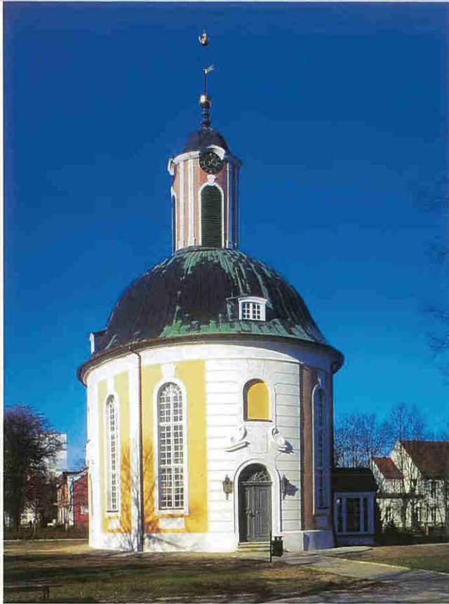
Die ehemalige französisch-reformierte Kirche in Schwedt/Oder, erbaut 1777–79
