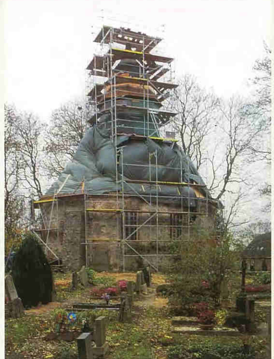
Die Dorfkirche von Grünberg während der Instandsetzung
