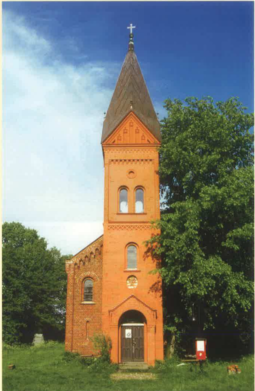
Dorfkirche Messdunk nach der Instandsetzung |
