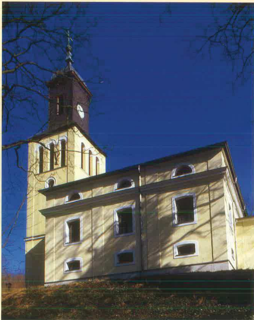
Neutornow, Kirche nach mehreren Umbauten (Foto: V. Thie)
