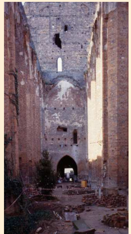
Blick in den zerstörten Innenraum
