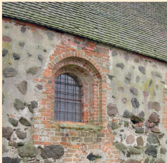
Königsberg, bereits in der Bauzeit zugesetzter Zugang, der in den vorbereiteten, jedoch nie ausgeführten nördlichen Sakristieianbau führen sollte; Foto: D. Schumann
