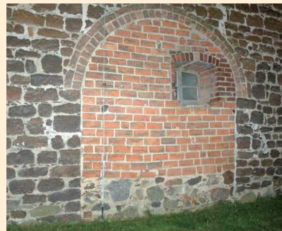
Dorfkirche Friedersdorf, vermauertes Westportal, Foto: Dirk Schumann
