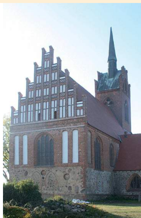
Ostgiebel der ehemaligen Wallfahrtskirche Alt Krüssow
