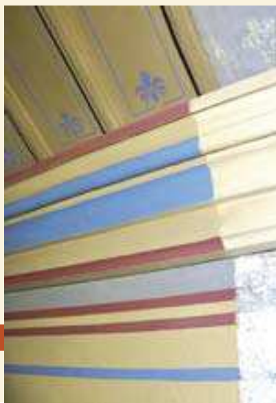
Detail der restaurierten bauzeitlichen Farbfassung
