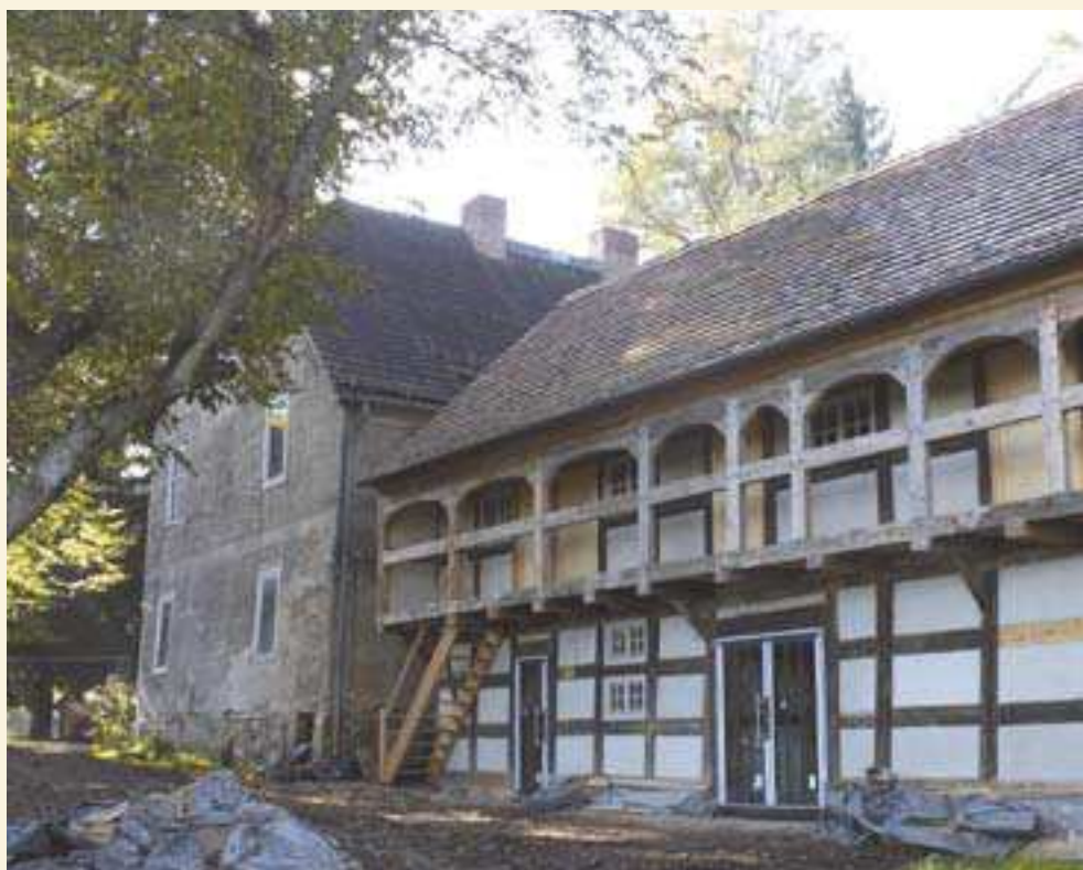
Das zukünftige Orgel- und Kulturzentrum: Oberlaubenstall in Lebusa während der Sanierung;
