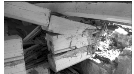
Bedrohlich: Schwammschäden
