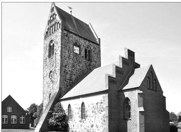
gibt. Das Turmmauerwerk ist u. a. von starken Rissen durchzogen und es lassen sich leichte Verformungen der äußeren Mauerwerkschale erkennen. Wie kam es dazu?
