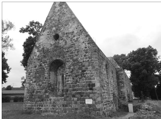
DIE KIRCHE von Dolgelin erhält ein neues Dach Foto: Autor
