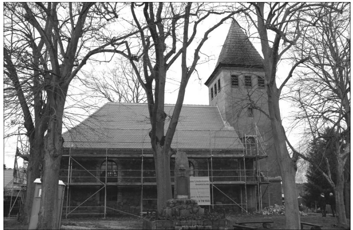
DIE BAUARBEITEN an der Kirche von Senftenhütte gehen zügig voran. Zur Zeit sind die Dacharbeiten in vollem Gange (Bild Fortgang der links) Fotos: Autor
