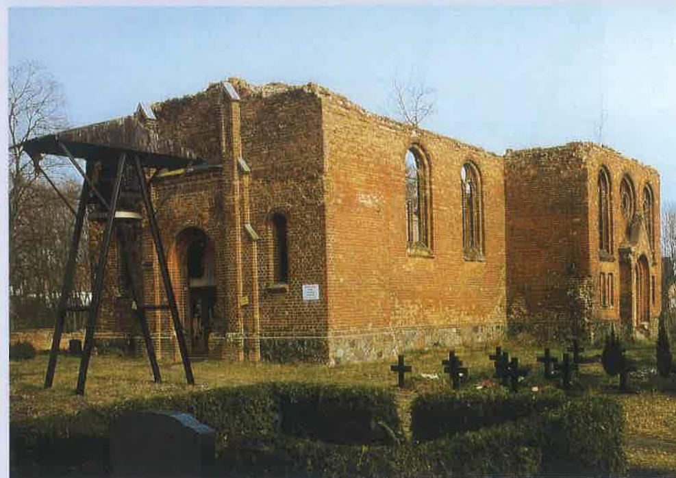
sehr weich und wird daher bei weiterem Frostangriff rasch zerstört. Die gravierendsten Schäden finden sich an der ungeschützten Mauerkrone. Diese wird um etwa einen halben Meter abgetragen und neu aufgemauert werden müssen. Außerdem ist hier dringend eine Zinkblechabdeckung erforderlich. Der Turmrest droht auseinander zu brechen. Hier werden ein einfacher Ringanker und gleichfalls eine Zinkblechabdeckung benötigt.
