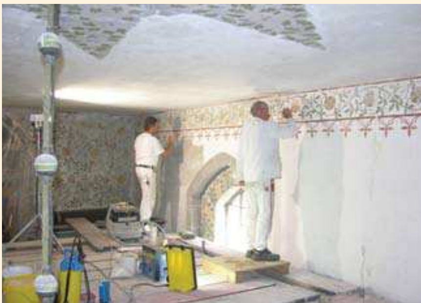
Dorfkirche Gortz (Potsdam-Mittelmark), Restaurierungsarbeiten im Innenraum
