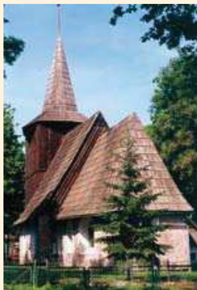
Dorfkirche Kalzig (Kalsk), ehem. Kreis Schwiebus-Züllichau, mit verbrettertem Schrotholzturm
