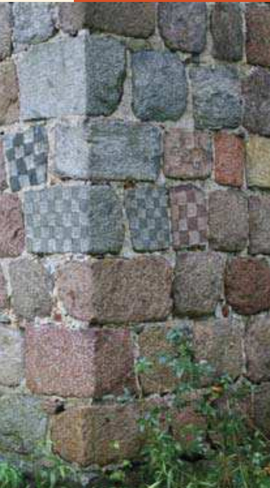
Grunow (Märkisch Oderland), sechs Schachbrettsteine, ein roter und ein gelber Quader, Fotos: Eberhard Bönisch
