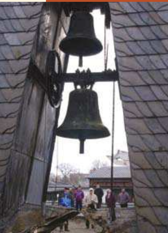
Demontage des Glockenturmes in Bornum
