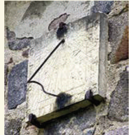
Steinplatte mit hübscher Verzierung: Röpersdorf (Uckermark), Ende 18. Jahrhundert, 45x45 cm, um den Fußpunkt ein stark ausgebildetes Sonnengesicht mit Flammenstrahlen, Restaurierung wünschenswert
