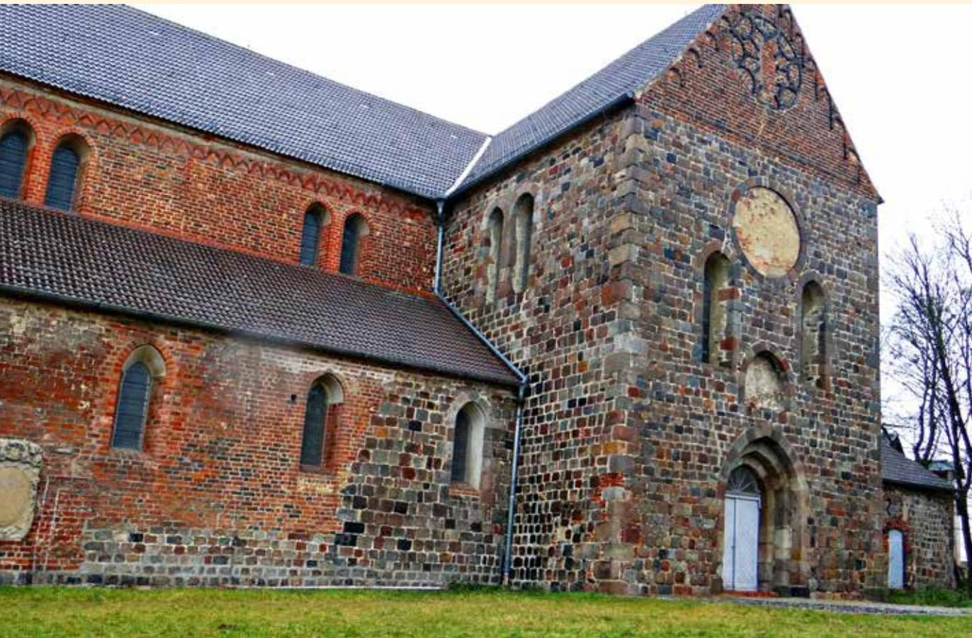
*Baunaht, Übergang vom Feldstein- zum Backsteinbau*
