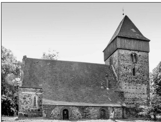
DAS GOTTESHAUS kann noch gerettet werden.
