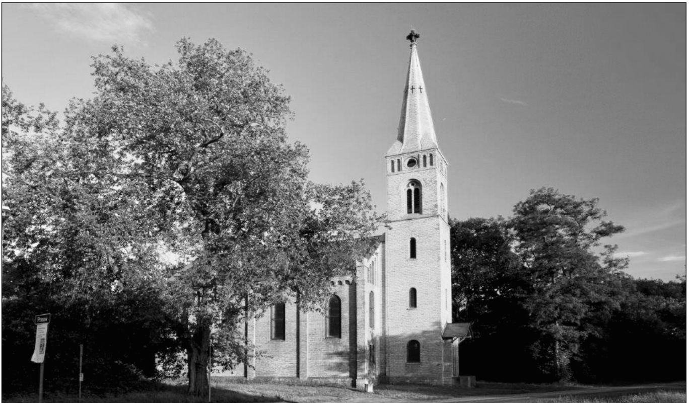
DER TURM sieht zwar sehr schön aus, aber die Haube muss erneuert werden.
