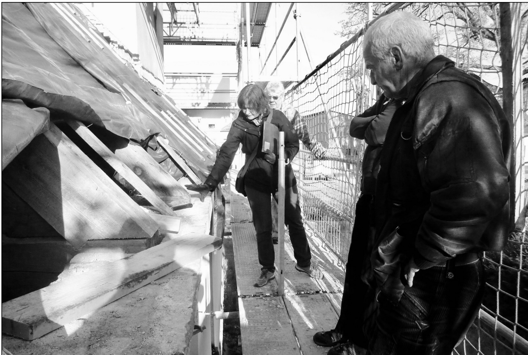
ARCHITEKTIN ANNEMARIE ROTHE bei der Bauberatung zur Sanierung des Traufbereichs des Langhauses mit Maurer, Dachdecker und Zimmermann Foto: Hans Tödtmann
