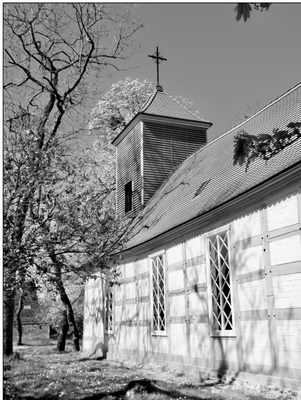
DIE SEEHAUSENER Kirche erstrahlt nach aufwendiger Sanierung im neuen Glanz Foto: Autor
