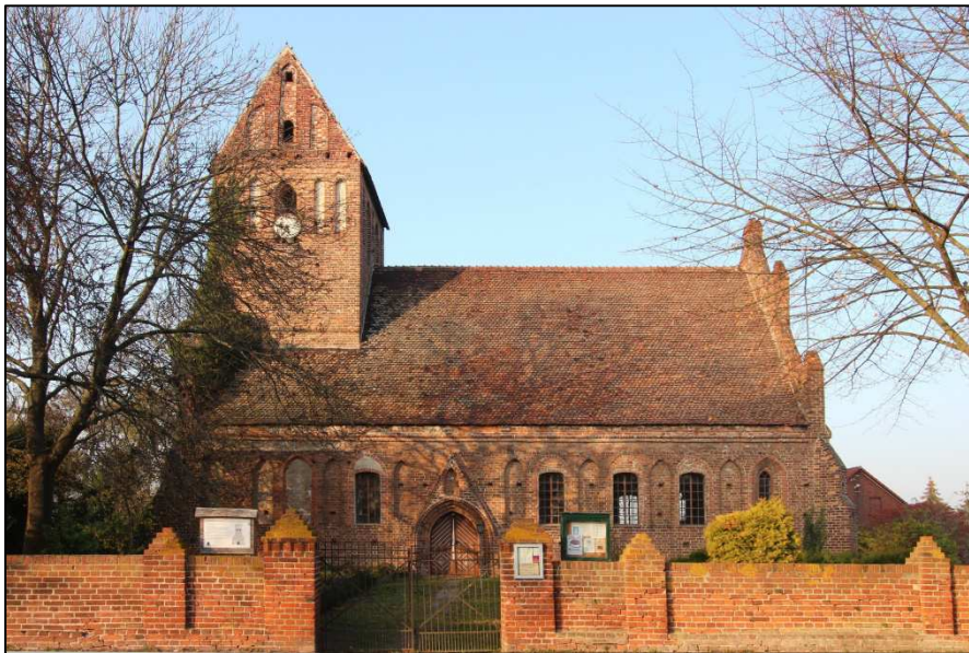
Dorfkirche Buckow (Havelland); Foto: Krekeler Architekten
