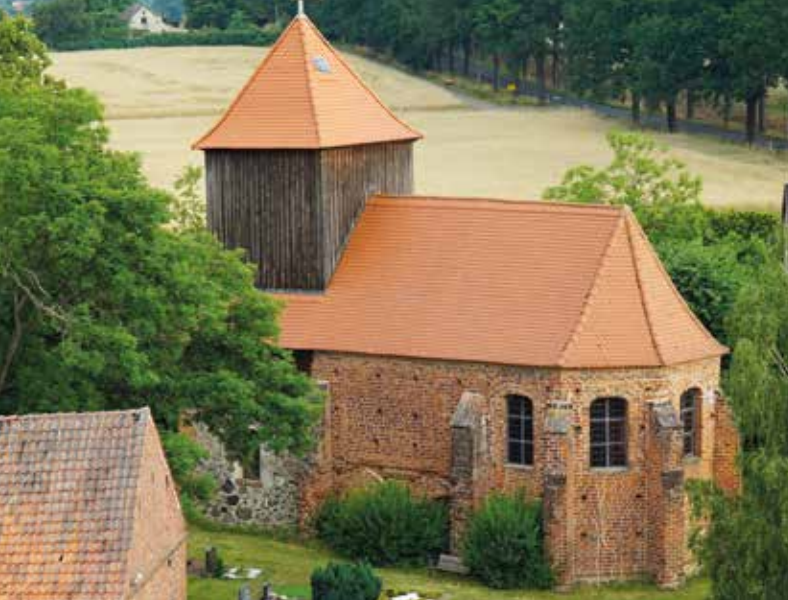
Südseite der Kirche
