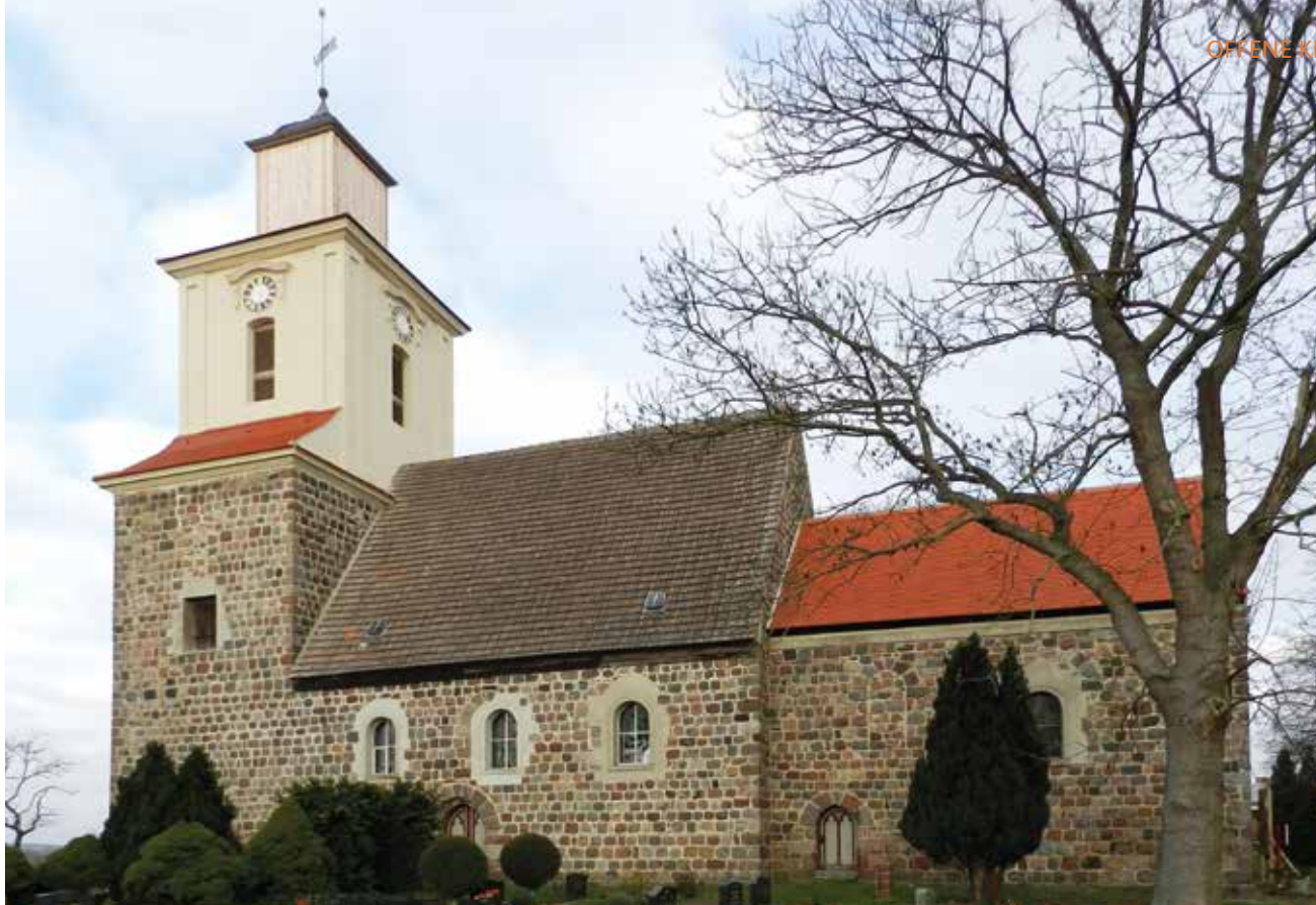
Dorfkirche Kerkow, Ansicht von Südosten nach der Sanierung von Chordach und Turmaufsatz
