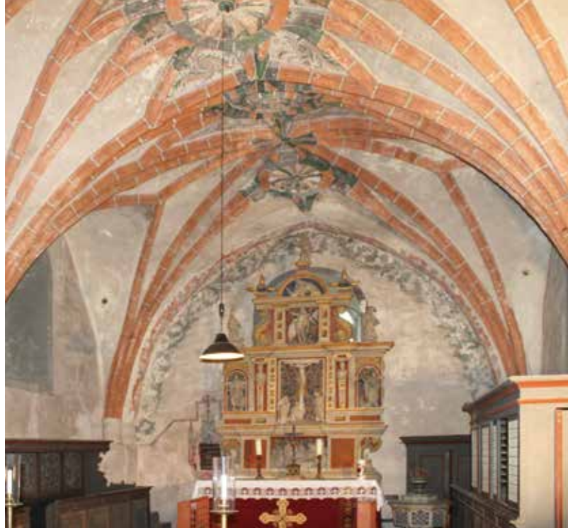
Blick in den gewölbten Chor
