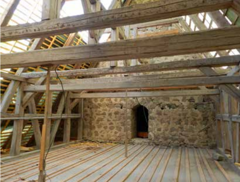
Blick in das Chordach nach Osten während der Sanierung
