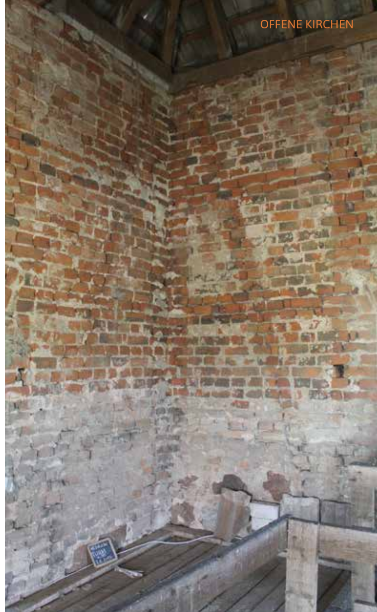
Turmaufsatz im Uhrengeschoss mit Spuren der nach dem Brand von 1974 herausgenommenen Fachwerkkonstruktion
