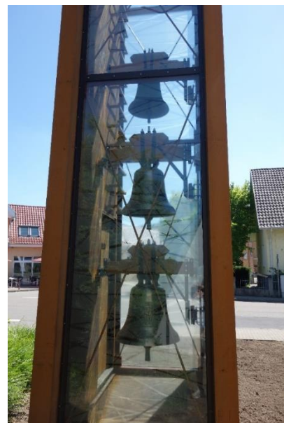
Glockenturm Sinzheim, Foto: Frank Hindorf
