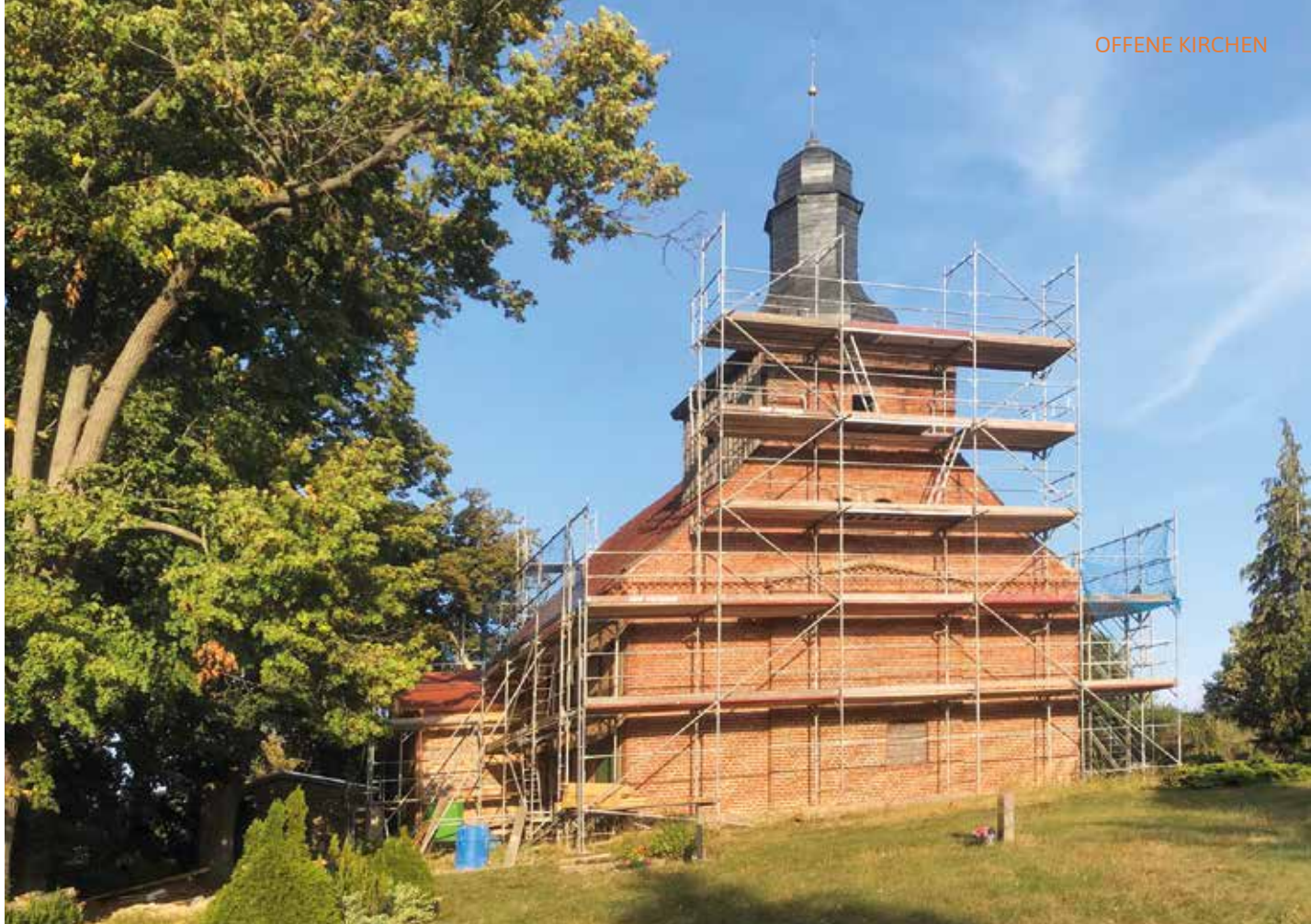
Die Landiner Patronatskirche während der Sanierung 2019
