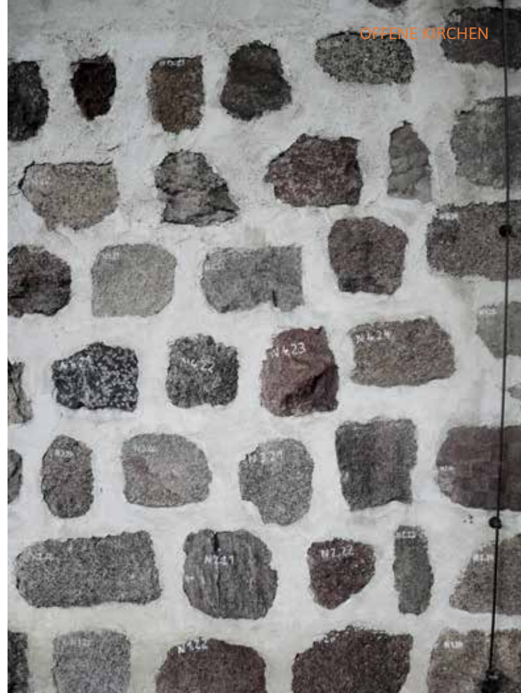
Die Auferstehungskirche in Spremberg stand bis 1988 noch in Pritzen. Aufgrund der geplanten Devastierung des Ortes wurde sie rückgebaut, vollständig eingelagert und 1990–1995 in Spremberg wieder aufgebaut.
