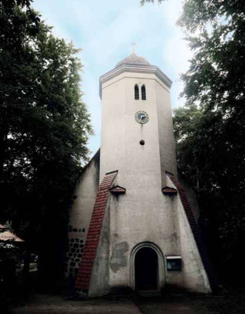
Die Auferstehungskirche in Spremberg stand bis 1988 noch in Pritzen. Aufgrund der geplanten Devastierung des Ortes wurde sie rückgebaut, vollständig eingelagert und 1990–1995 in Spremberg wieder aufgebaut.
