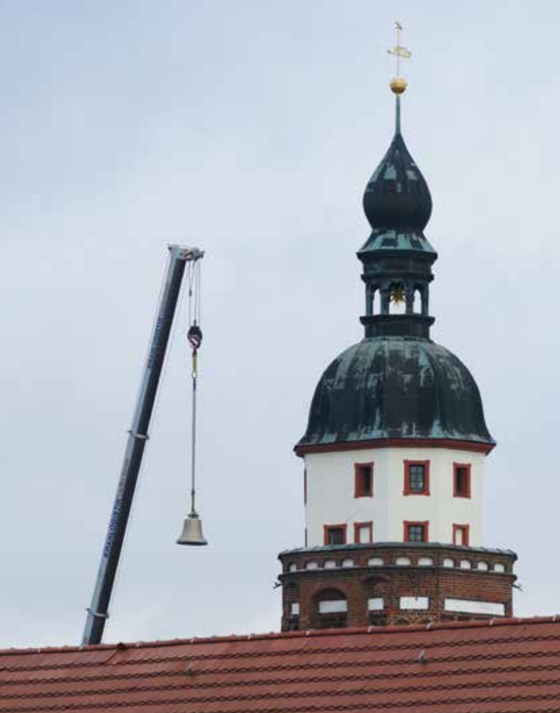
Am 7. Dezember wurden die Glocken per Kran in den Kirchturm eingehoben.
