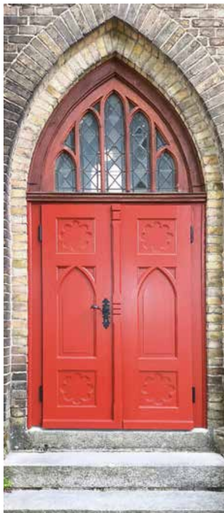
Die südliche Kirchentür in Friedersdorf (Dahme-Spreewald) konnte mit Unterstützung des FAK saniert werden.
