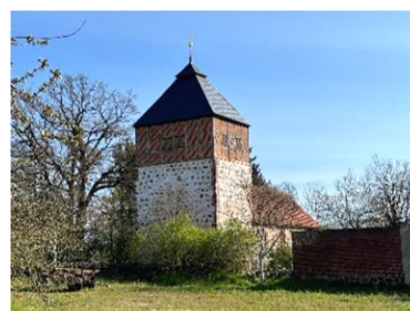
Kirche Tacke mit saniertem Turm, Foto: Matthias Wieck
