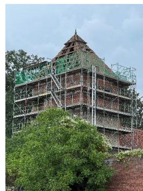
Turmsanierung der Dorfkirche Tackenberg, Foto: Matthias Wieck
